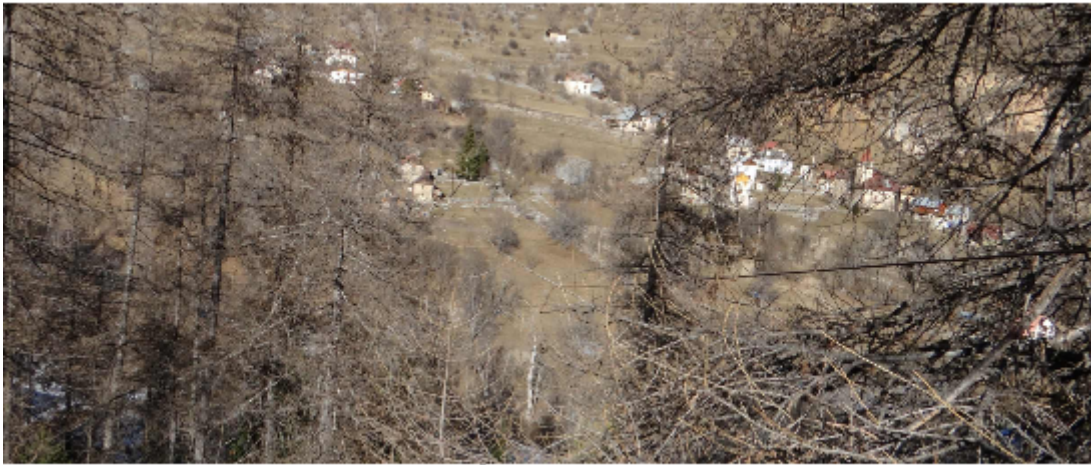
Site de Roya : câble avant l'enlèvement
