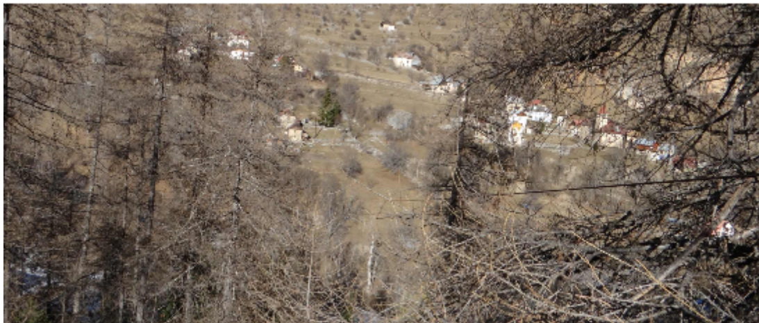
Site de Roya : câble avant l'enlèvement
